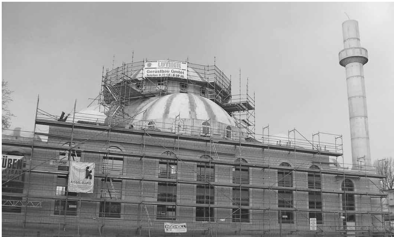
Foto: Moschee Duisburg-Marxloh im Bau. Quelle: Wikipedia
