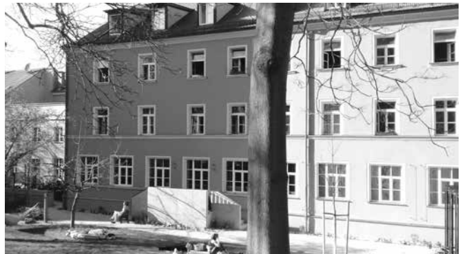
Marienstift 2018: Im Erdgeschoss die ESG, darüber Wohnungen
